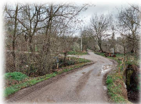
сл. 97: Мост на Столској реци
